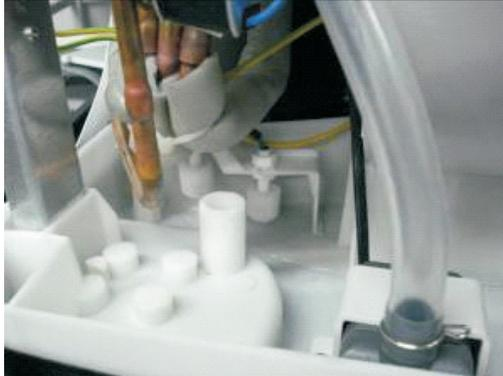
Desconectar o cabo de alimentação da bóia de dreno primária da placa eletrônica;
